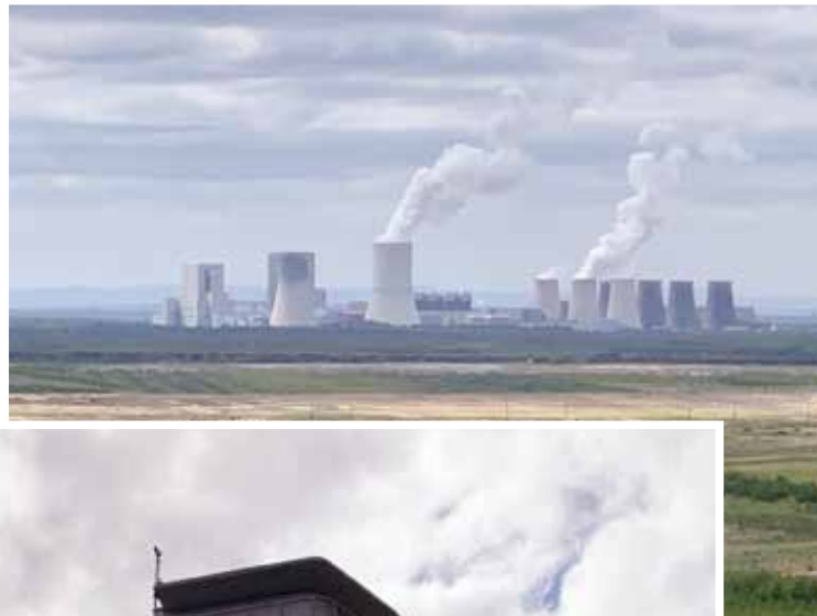
Kraftwerk Boxberg mit Tagebau im Vordergrund
